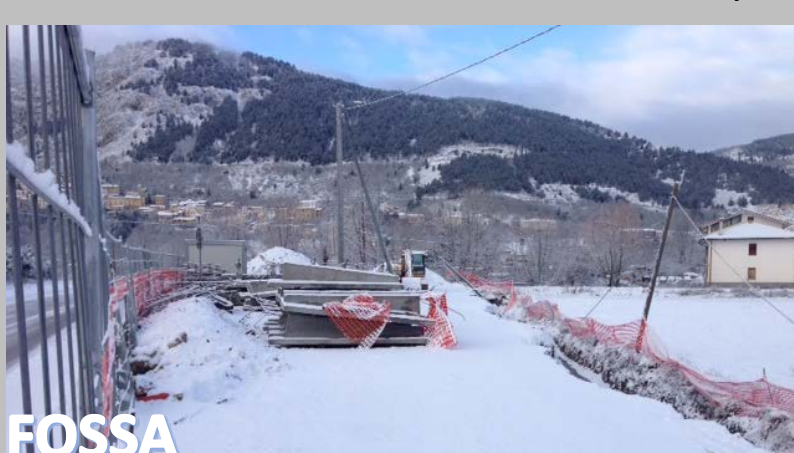
Consolidamento muro stradale € 100.000,00
