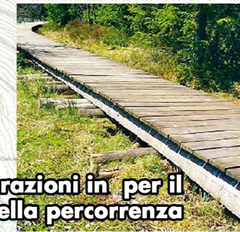
Interventi di contrasto all'erosione del Tracciato
