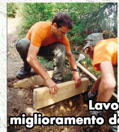
Interventi di contrasto all'erosione del Tracciato
