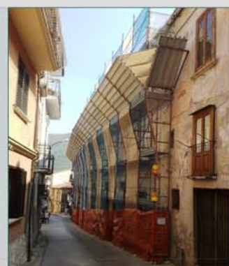
Partenza ristretta dim. 0,35 cm a telaio prefabbricato
