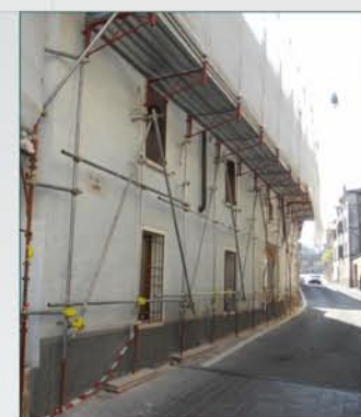
Partenza "a zero" a tubo e giunti
