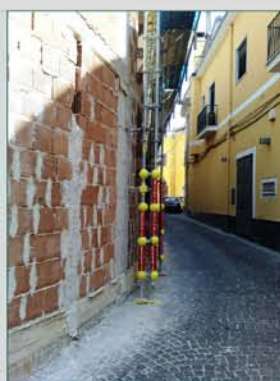
Partenza ristretta dim. 0,20 cm ponteggio multidirezionale
