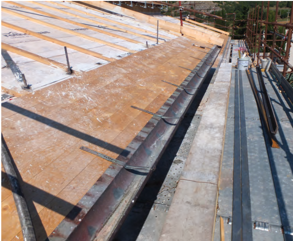
perniature cordolo copertura e controventatura
