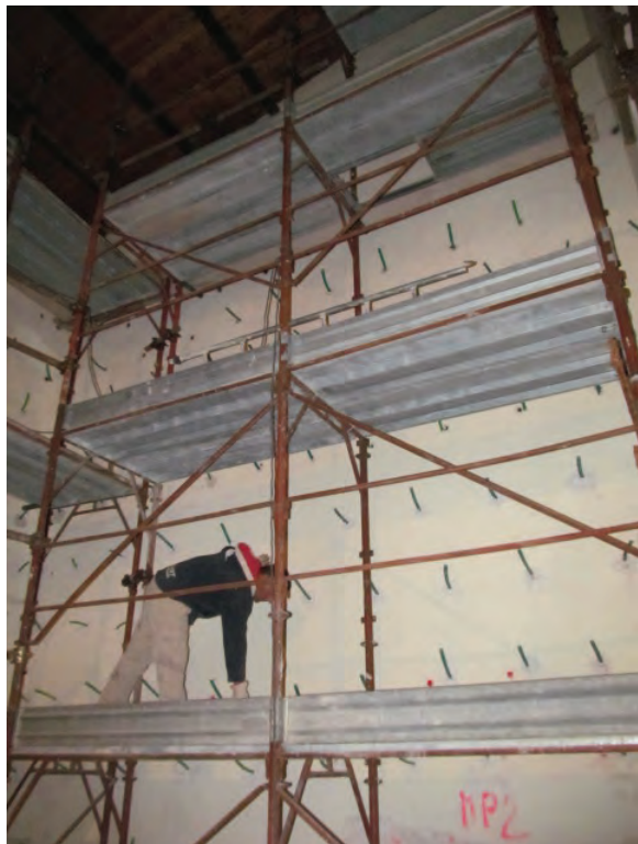
consolidamento delle murature perimetrali
